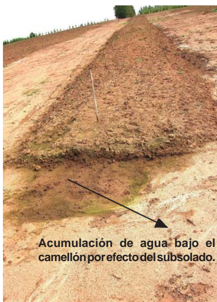
Figura 6. Cantero drenando agua.
