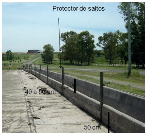
Fotografía 3-3 Alturas sugeridas para el protector de saltos
