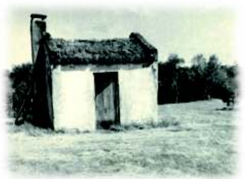
Una de las primeras instalaciones de Paso Laguna
