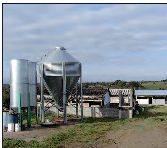
Figura 12. Silo para almacenaje de ración o grano, presente en la mayoría de las explotaciones de más de 500 cerdos.
