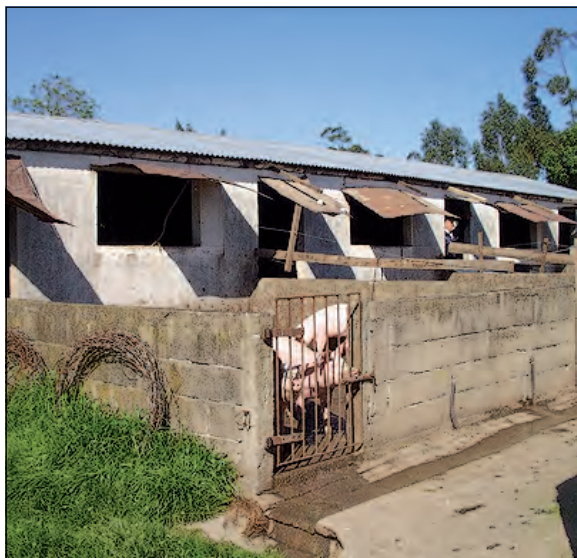
Figura 7. Materiales predominantes en los galpones: piso de hormigón, paredes de mampostería y techo de chapa.
