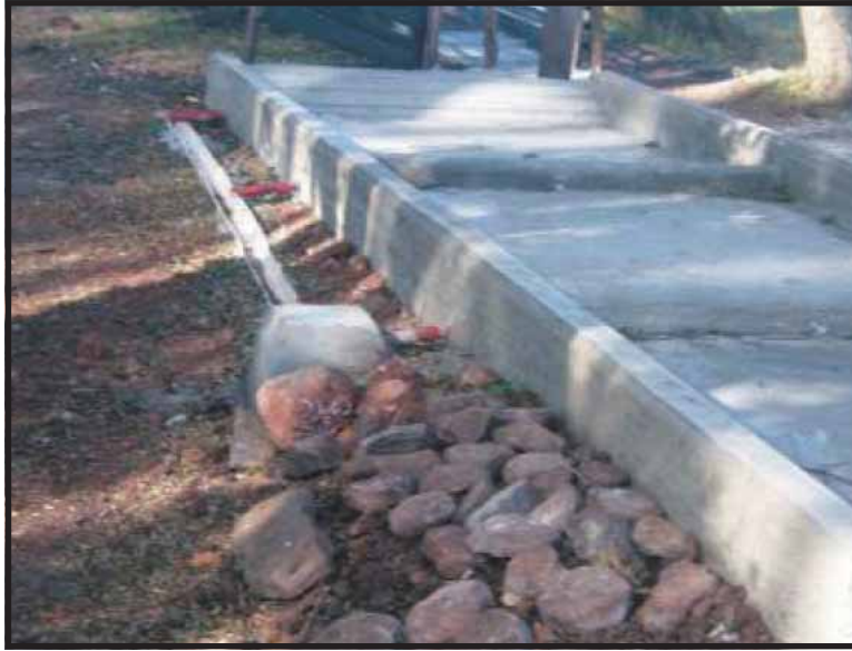
Figura 7. Piso, pendiente y desagües.
