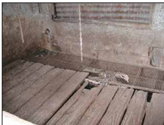
Local de posdestete (interior)
