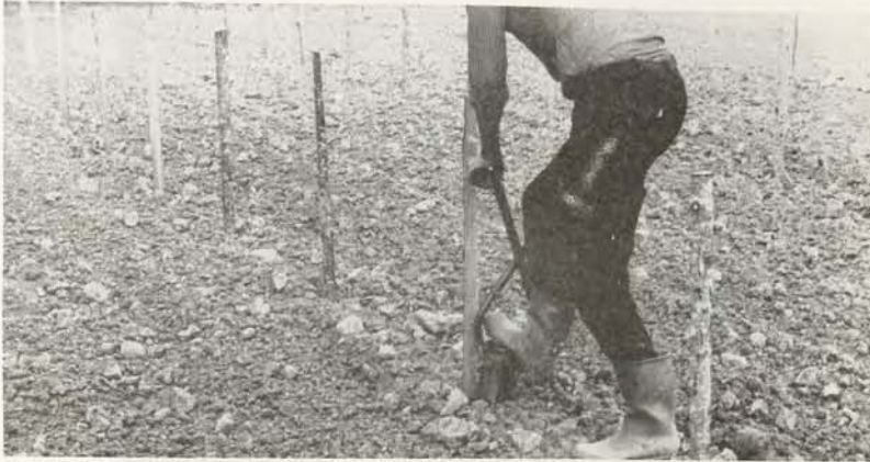
Figura 5. Pala especial utilizada para la confección de pozos, Francia, 1973.
