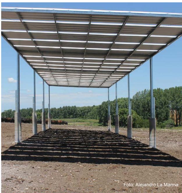
Figura 2 - Sombra de chapas de 4,1 m de altura con espacio entre las mismas.
