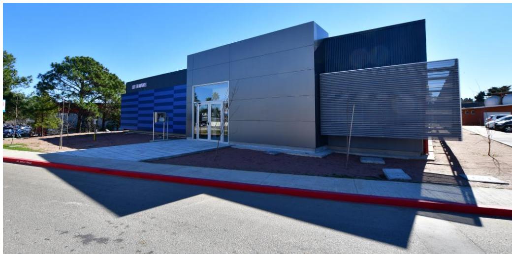
Estructura externa del edificio “Los Guayabos”.
